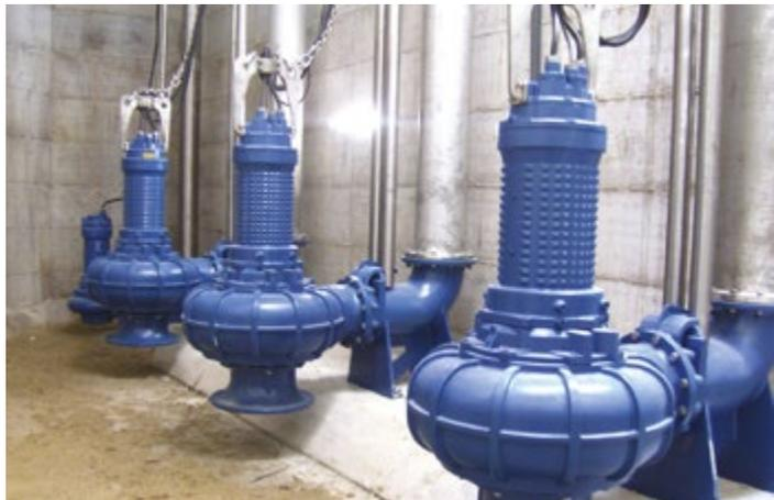
Le catene zincate a fuoco, o in acciaio inossidabile, vengono utilizzate per l'immersione delle pompe idrauliche in vasche e serbatoi.
